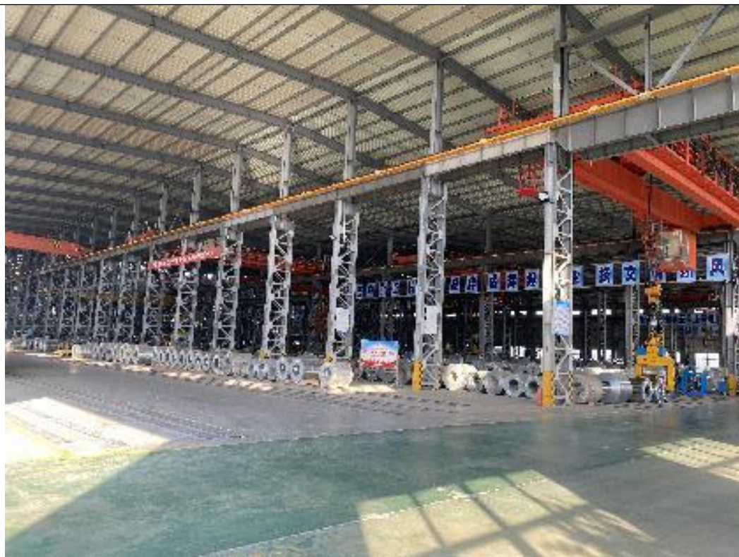
仓储区：仓储区地面完好无破损。
